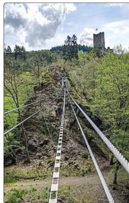
Die herausfordernde Seilbrücke im 3. Abschnitt
