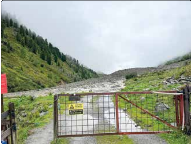
Fahrstraße Richtung Taschachhaus: Ein Bach und Muren versperren im August 2023 den Weg. Foto: DAV-Sektion München
